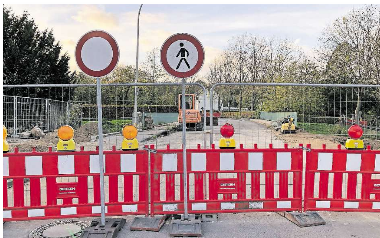
Ein Jahr lang ist die Brücke in Zweibrüggen für Autos, Fahrradfahrer und Fußgänger gesperrt.
